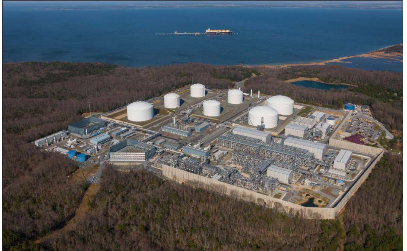
Cove Point LNG Plant
